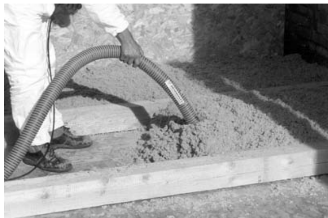
Soufflage sur planchers de combles
